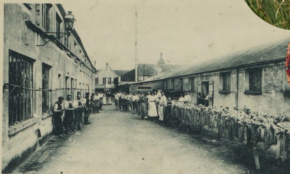
DAMMARTIN-EN-SERVE (S.-et-O.) — Cour intérieure de l'Usine de Sparterie
