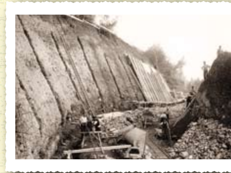
Chantier de la route (cl. P. Fourchy - ONF Isère)
