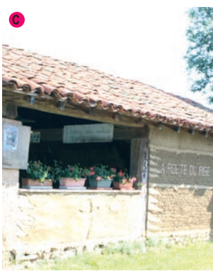
C Abri en pisé construit par l'association "les Amis du Chapi".
