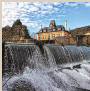
Centrale hydroélectrique d'Ambialet @patprp
