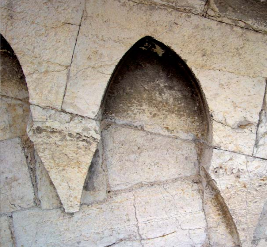
Détail d'une arcature lombarde : elle suit l'inclinaison de la toiture
