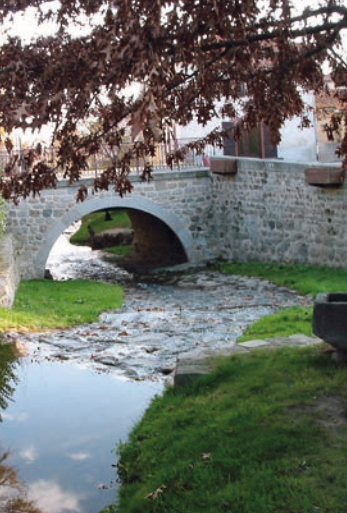
Le pont de Ruillat
