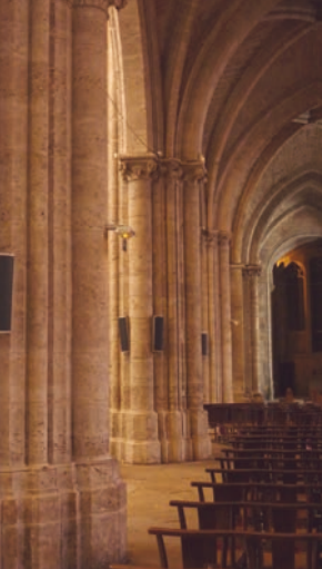
Détail de la nef L'effet ondulant des colonnes et colonnettes s'observe depuis les collatéraux Photo © Pays du Forez
