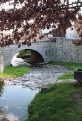
Le pont de Ruillat
