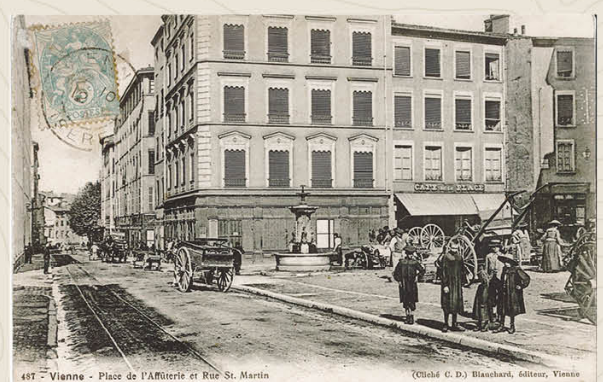
1897 - Vienne - Place de l'Affûterie et Rue St. Martin (Cliché C. D.) Blanchard, éditeur, Vienne
