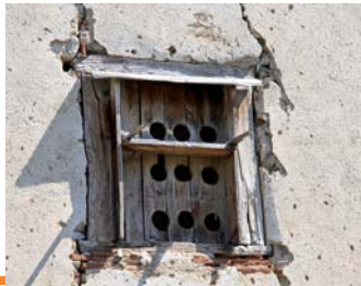
Fuiies du pigeonnier de Pressat, permettant le passage des pigeons, que l'on fermait à l'aide d'un volet.
