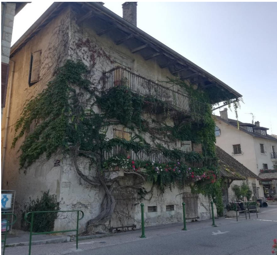
Maison des douanes déplacée dans le village
