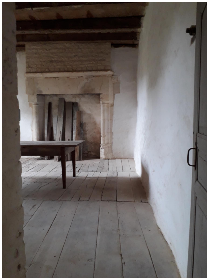
Logis de Tessé, travaux réalisés suite au partenariat entre ARSIMED et LABARACHA exposition et leurs bénévoles
