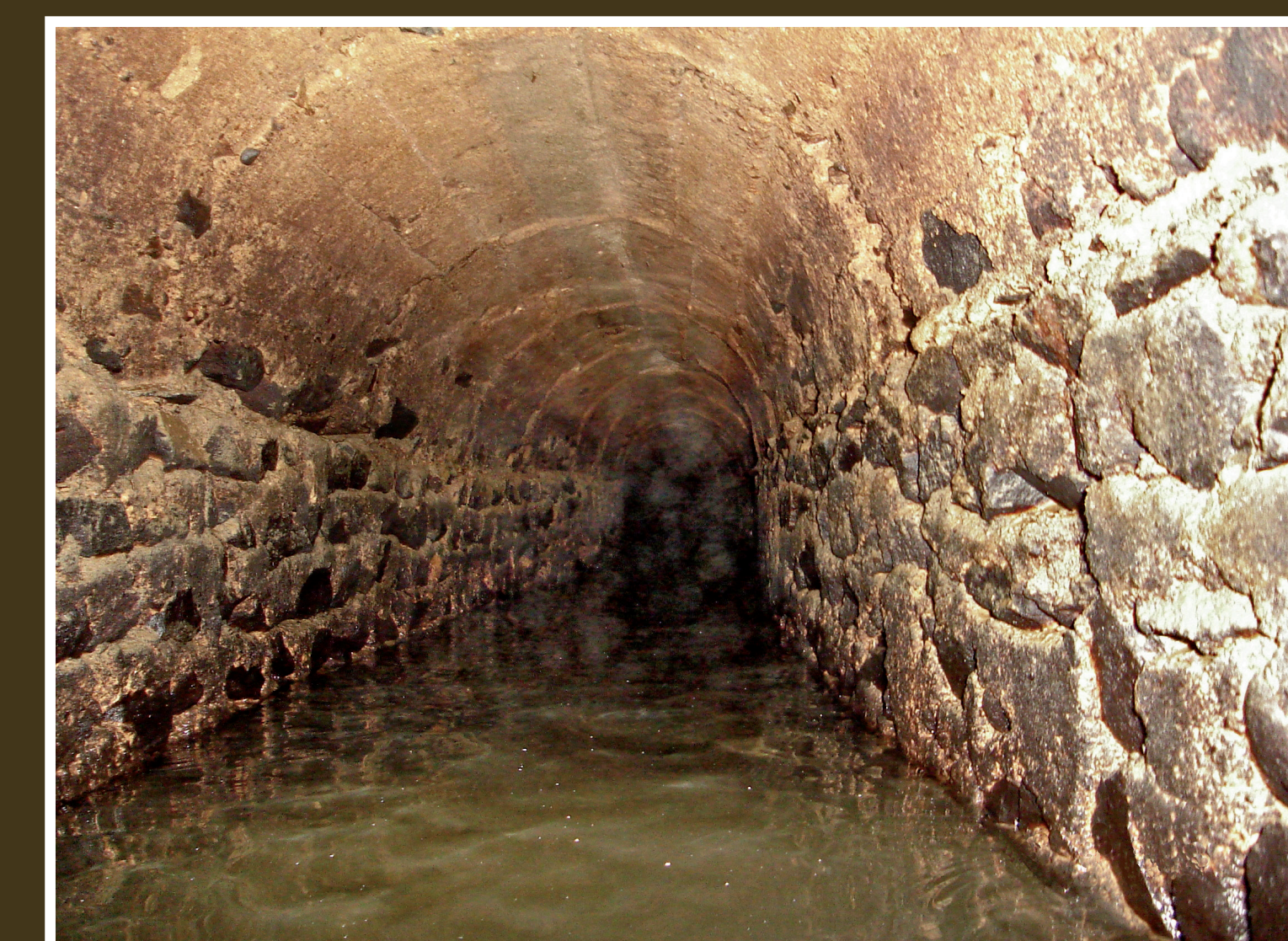
Le canal a conservé à la voûte l'empreinte des planches des cintres de construction. Texte et photo: J. BURDY, H. BOUGNOL, D. MACHO - L'Arrière - OCRA.
