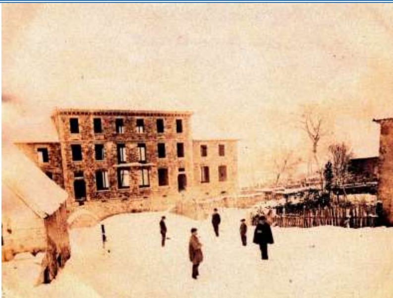
Chantier mairie-écoles de Celles / hiver 1894
