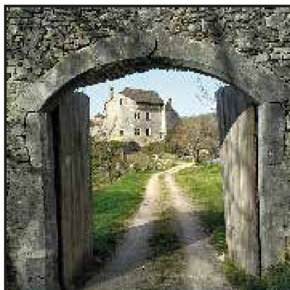
Entrée de la Maison Forte
