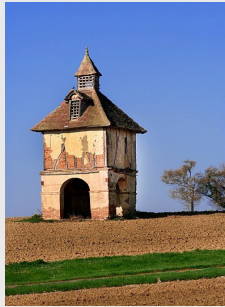
Pigeonnier gascon, toit pyramidal à quatre pentes
