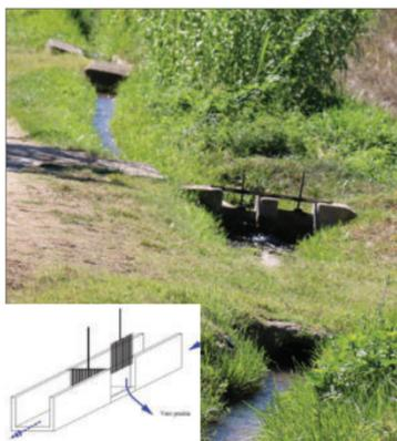
« Espargier » ou « martellière » d'irrigation permettant aux usagers du canal de détourner son flux principal vers leurs terres – Etude hydraulique du Plan Local d'Urbanisme de Châteauneuf-de-Gadagne.
