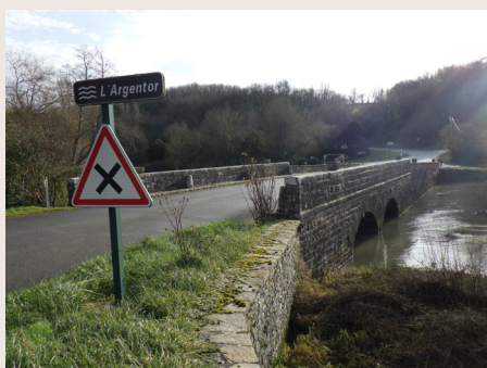
Pont sur l'Argentor à Pougny
