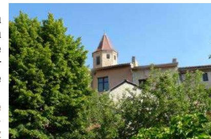
Hospice vu du chemin des Effossés
