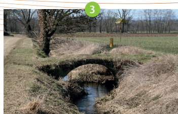
Pont de la Vesne
