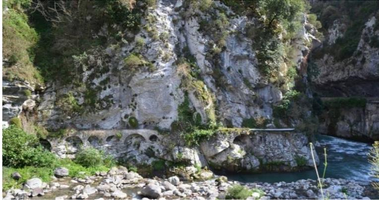
*Vue des arcades de soutènement du canal de Nocé, en rive gauche de la Roya. Peu avant l'entrée des gorges, la maçonnerie effondrée a été remplacée par un tuyau. (cliché © Patricia Balandier)*
