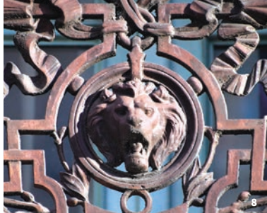
8. Garde-corps de balcon © Maison du patrimoine – Ville d'Uzès
