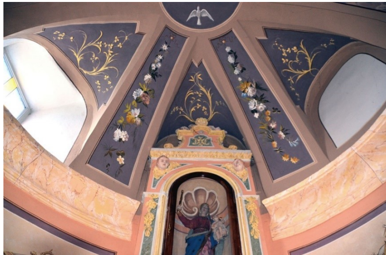
Voûte du chœur. (cliché © Patricia Balandier)
