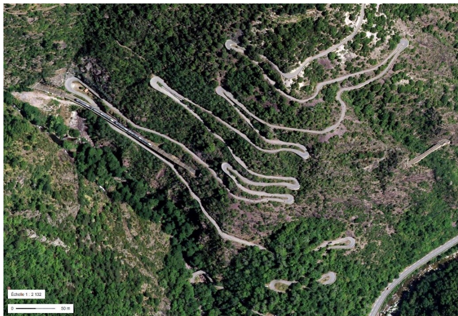
Vue zénithale de l'empilement de lacets de la route de Berghe. (© geoportail.gouv.fr)
