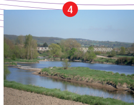
Pont de la Loire
