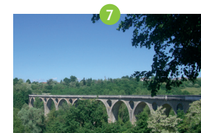
Viaduc de Chessieux
