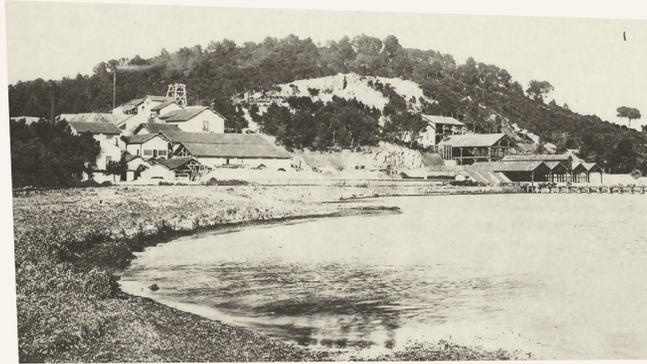
Cette importance est due à la quantité et à la qualité de blende extraite (340 000 T à 50-60% de zinc) et au perfectionnement des ateliers de préparation mécanique. **À la pointe de la technologie de l'époque**, ils permettaient de traiter jusqu'à 214 T de minerai par jour.
