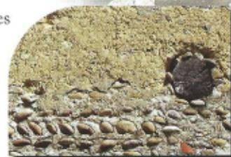
Tout comme dans les murs des maisons ou dans les champs du Chambaran où ils sont utilisés pour réaliser des drains (**douillères**), les galets sont présents en abondance dans les rues du bourg. Cette calade, aux galets brisés par moitié et soigneusement disposés dans un mortier, est l'une des dernières de Roybon à ne pas être masquée par un revêtement moderne.
