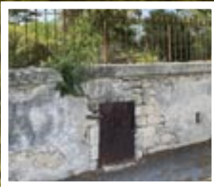
1 La source du Montadou, aménagée dans un mur de propriété
