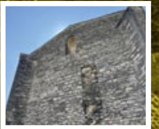
6 Façade Est de l'église, montrant la jonction avec les remparts aujourd'hui
