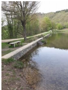
Digue de l'étang
