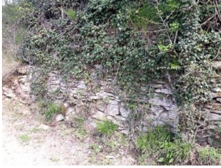
Muret en pierres sèches construit avec des calcaires du site
