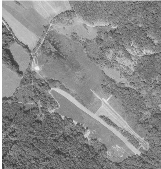
Photographie aérienne historique de 1978 (IGN), travaux dans le chenal de l'étang, aménagement de la piste et d'une zone cultivée
