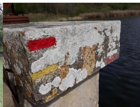
Marquages des cheminements sur la bonde de l'étang
