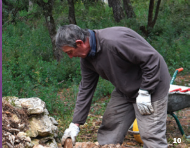
10. Chantier de rénovation © Maison du patrimoine – Ville d'Uzès
