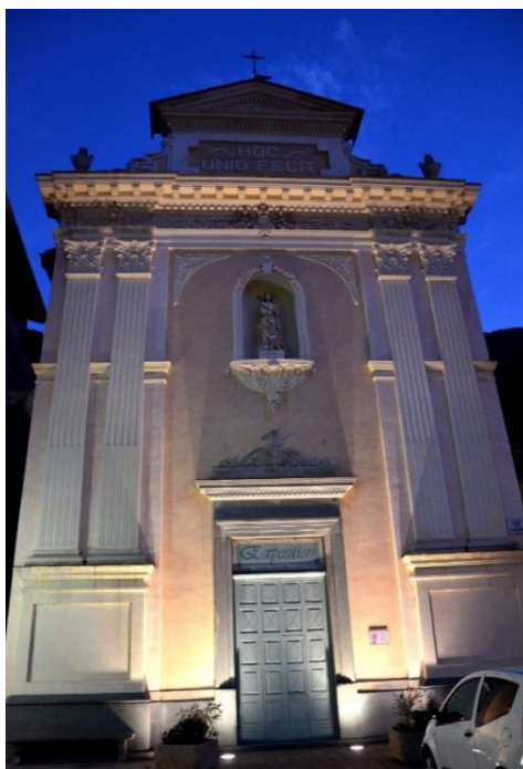
Vue nocturne de la façade nord de la chapelle Sainte-Catherine. (Cliché © Patricia Balandier)
