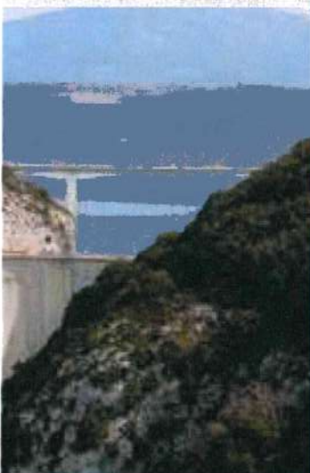
Le barrage de Sainte-Croix
