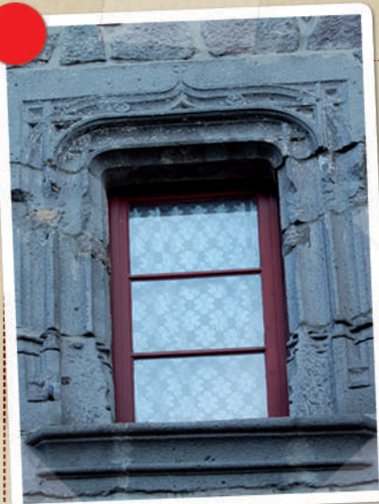
Fenêtre renaissance à moulures et accolades.
