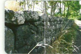
La technique de construction "**pier sèche**" fut mise en œuvre dans les constructions néolithiques (6000 et 2500 avant J.-C.). Cette technique d'empilement de pierre permet aujourd'hui encore de soutenir des chemins, routes, voies ferrées, de créer des murs de séparation, des terrasses (gain de surface cultivable). Ces constructions qui dessinent les paysages témoignent de l'art des "paysans bâtisseurs"
