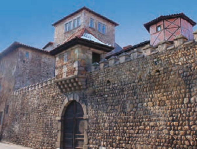
La construction de la maison du Colombier a combiné différents matériaux : galets, pierre grossièrement équarries, briques et pans de bois.
