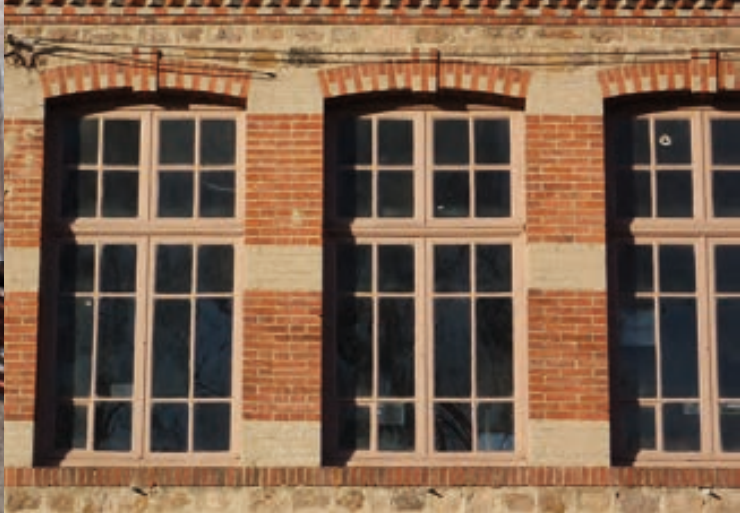
Hautes fenêtres d'atelier de passementier (quartier du Port).
