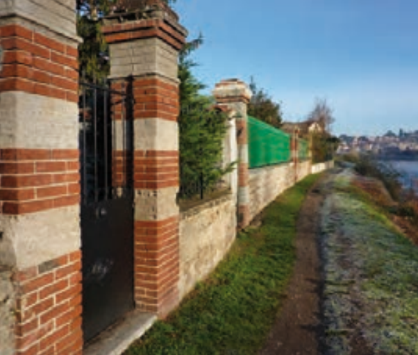
Murs bahuts à décor de brique et grilles finement ouvragées. Assortis au style de la maison, ils marquent la limite entre jardins privés et bords de Loire.
