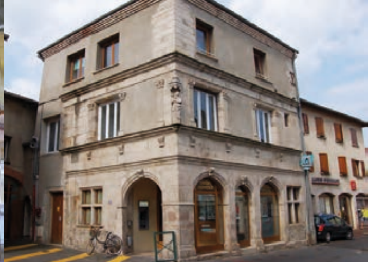
La Maison Renaissance a conservé ses arcades boutiquières en rez-de-chaussée.
