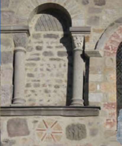
Détail du clocher-porche : l'arcature aveugle est encadrée de deux colonnettes surmontées de chapiteaux sculptés. Un motif en résille est visible sous l'arc. En bas, une roue solaire aux branches en tuileau rouge est encadrée de deux dalles (époque gallo-romaine ?)
