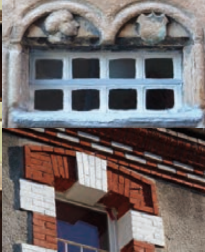
• Détail d'une baie style Renaissance, rue Chappelle. • Ici peintes, les briques forment un motif de damier.
