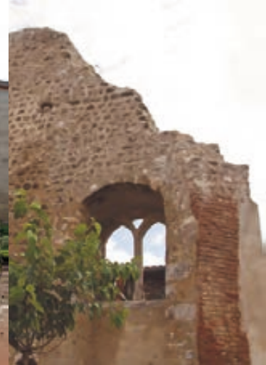
Baie jumelée correspondant à une ancienne demeure adossée au rempart.
