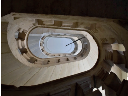
Escalier ovale. Hôtel Danger ©Maison du patrimoine – Ville d'Uzès
