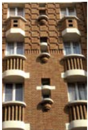
Immeuble de rapport. 14, avenue Georges-Clemenceau.
