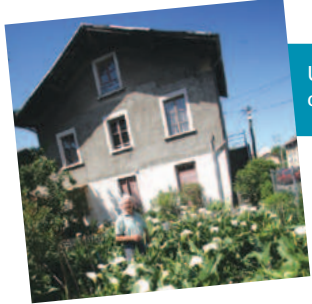
Une des maisons de la rue Billon
