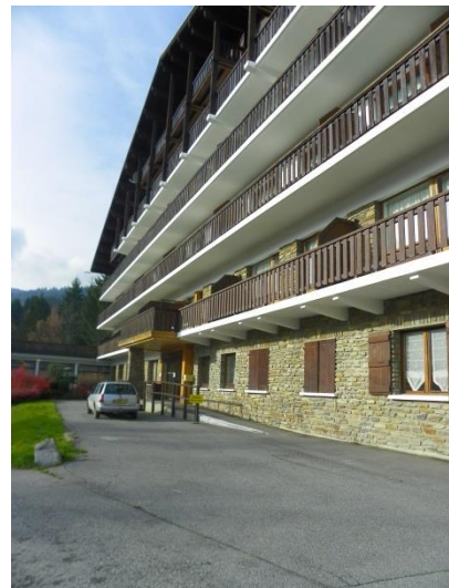
Accès à l'entrée – dépose minute
