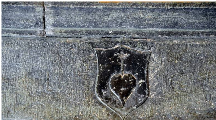
Ancien linteau (ouverture condamnée) dans la loggia de l'ancien palais. Cœur surmonté d'une croix dans un écu. (cliché © Patricia Balandier)
