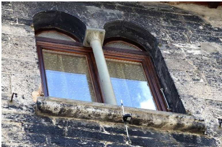
Maison médiévale rue Cotta. (cliché © Patricia Balandier)
