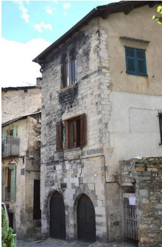
Maison médiévale rue Cotta. (cliché © Patricia Balandier)
