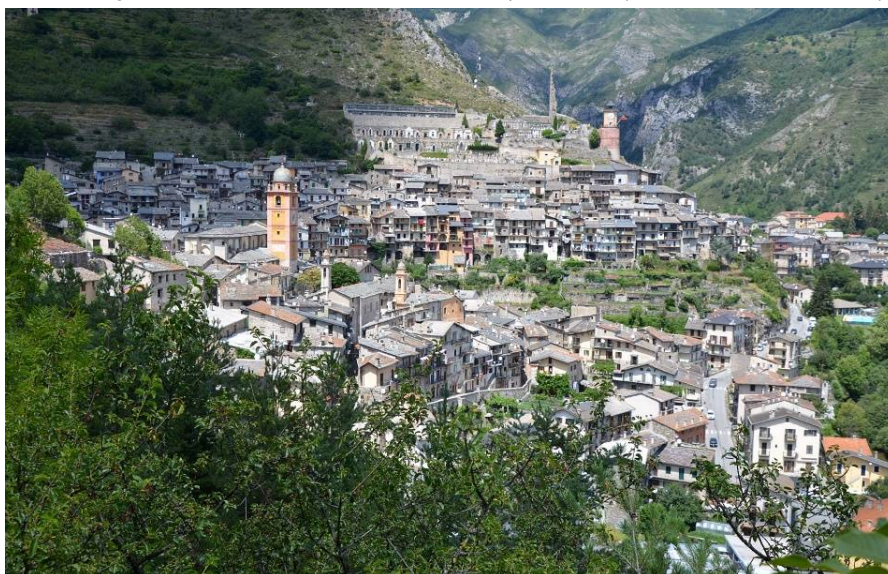
Vue du village de Tende depuis le sud. (cliché © Patricia Balandier)
