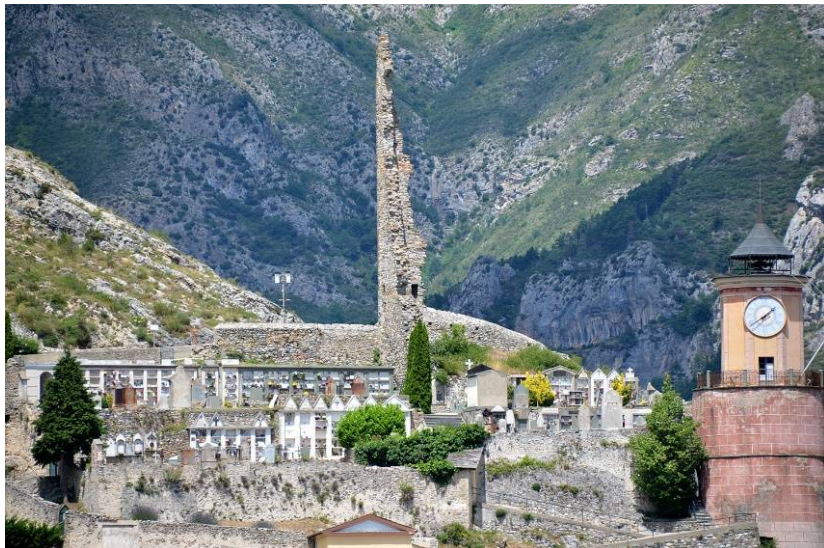
Vue du site de l'ancien château devenu cimetière en 1882. Tour sud-est du château du village et désormais surmontée d'une petite tour de l'horloge. A gauche vestige de l'angle nord-ouest de la grande tour carrée. (cliché © Patricia Balandier)
