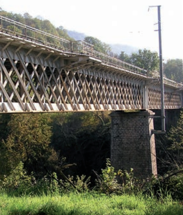
Le pont ferroviaire de type Eiffel. C.Maurel
