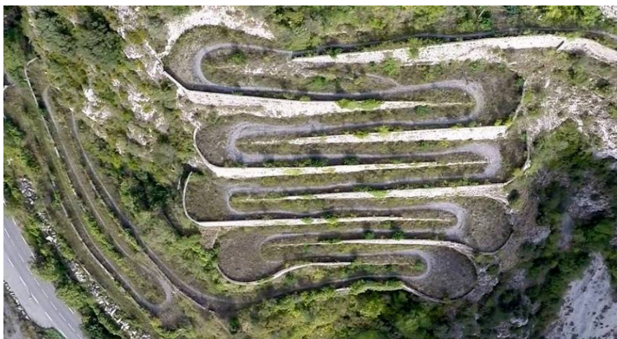
Vue zénithale des lacets de la route d'Ambo. (cliché © Vincent Jacques / Drône de Regard)
