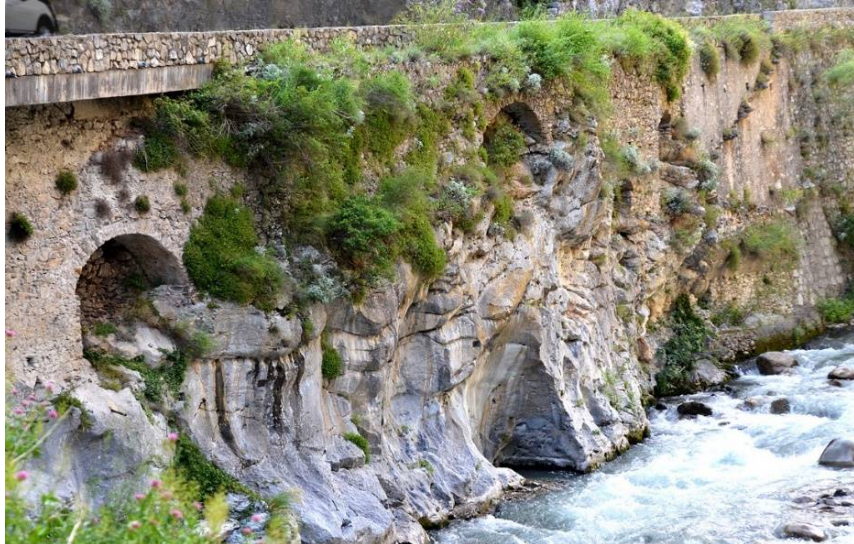
Soutènement de la route des gorges de Nocé. (cliché © Patricia Balandier)
