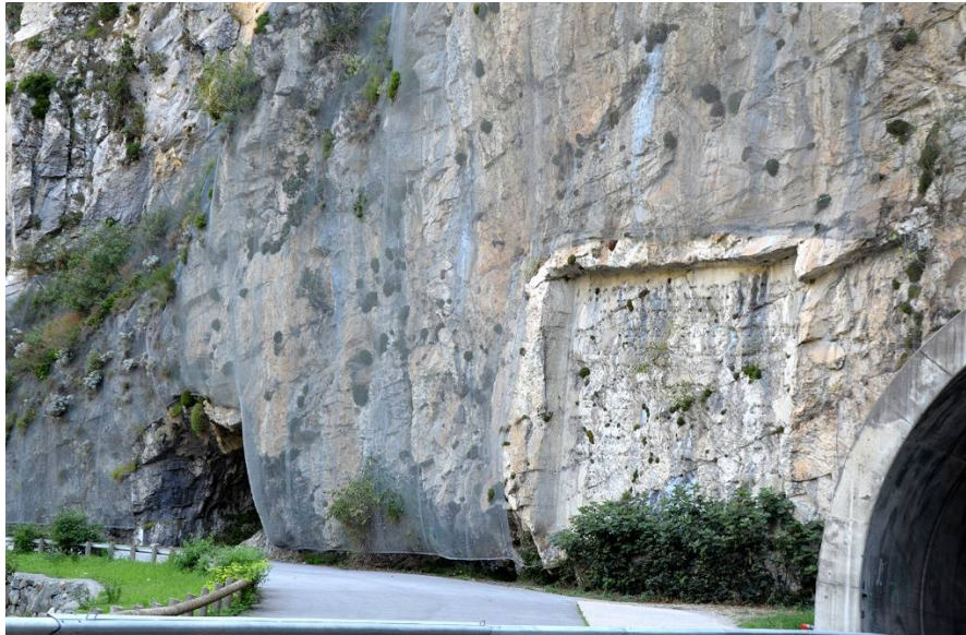
Plaque de 1784 vandalisée par les Révolutionnaires français evr 1794, entre la sortie nord du tunnel moderne et une ancienne tentative de percement. (cliché © Patricia Balandier)
