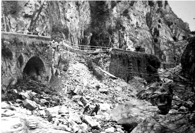
Eboulement local de la chaussée dans les gorges de Saorge en 1959. (Collection JL Taylor)
