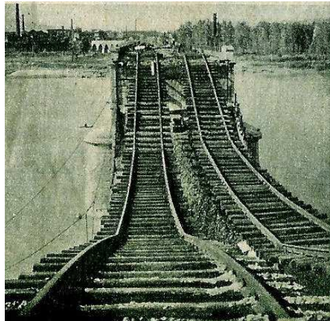
Arche détruite en 1944
