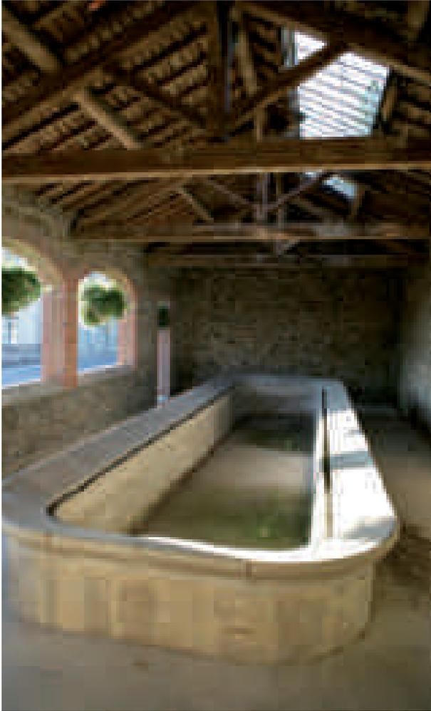
Il fut construit en 1923 lorsque la commune fut enfin alimentée en eau par des captages réalisés sur les hauteurs des communes voisines. Ce grand réservoir était divisé en deux bacs l'un destiné au dégrassage et lessivage du linge, l'autre réservé au rinçage.
