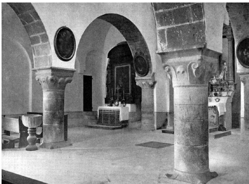
Vue de la nef et du collatéral nord. (Source J. Thirion)
