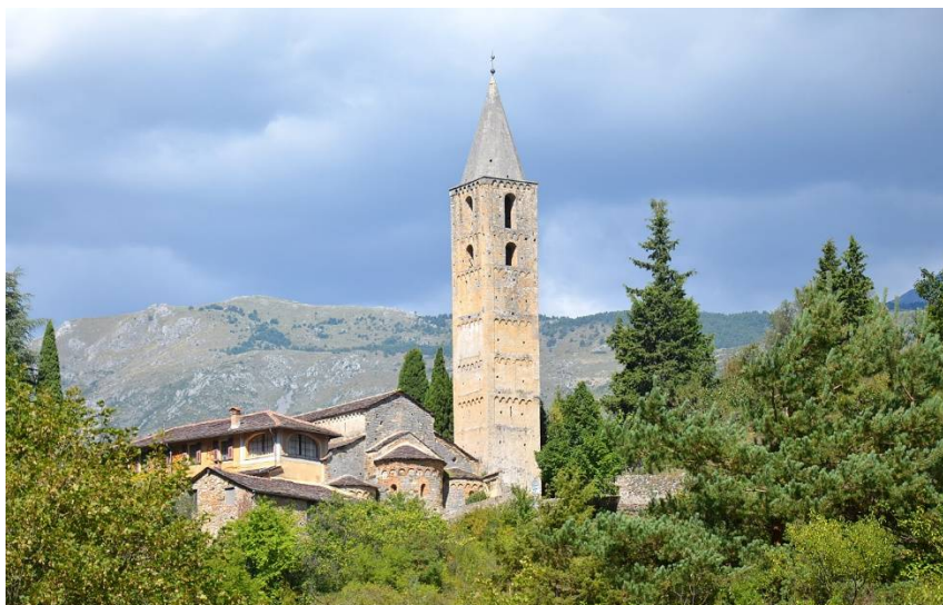
Vue d'ensemble depuis l'est. (cliché © Patricia Balandier)
