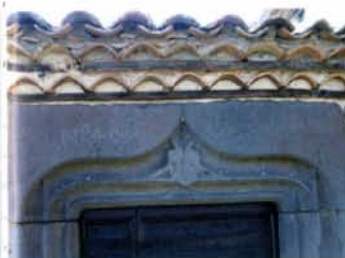
Linteau du jardin de l'ancienne école
