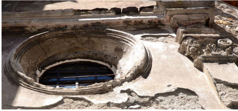
Détail du décor de façade du XVIIe siècle endommagé. (cliché © Patricia Balandier)
