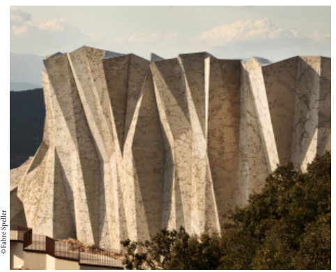
Grotte Chauvet 2 - Ardèche (bâtiment extérieur)
