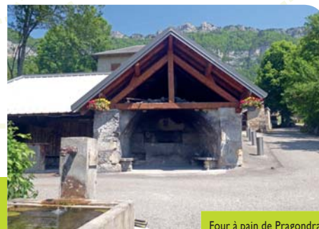
Four à pain de Pragondran
