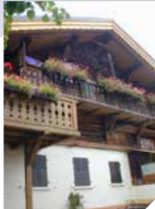
Construite en 1686. A remarquer : la contrefiche sous le faitage du toit.
