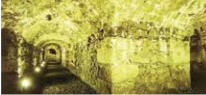
Galleries du rez-de-chaussée de la Porte Saint-Antoine
