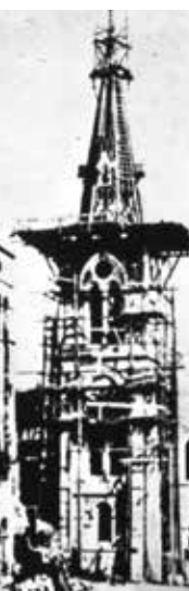
Chantier du nouveau clocher
